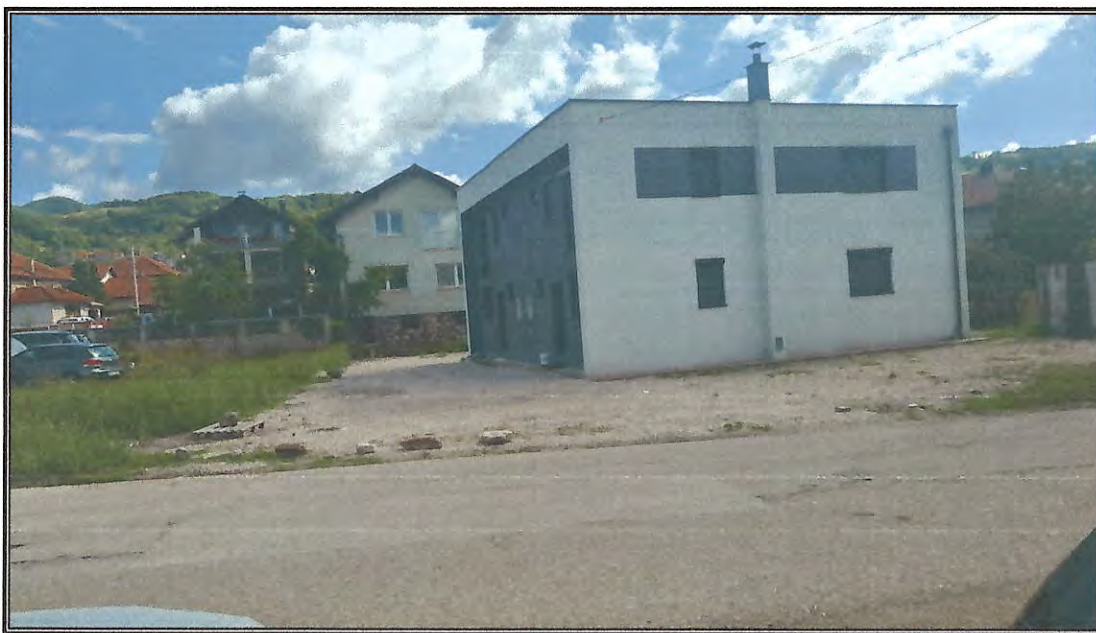
Sl. 1 Zatečeno stanje parcele (k.č. 1411 KO.Ričica) izgrađena i tamponirana
