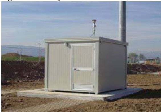
izgled fiksne mjerne stanice
